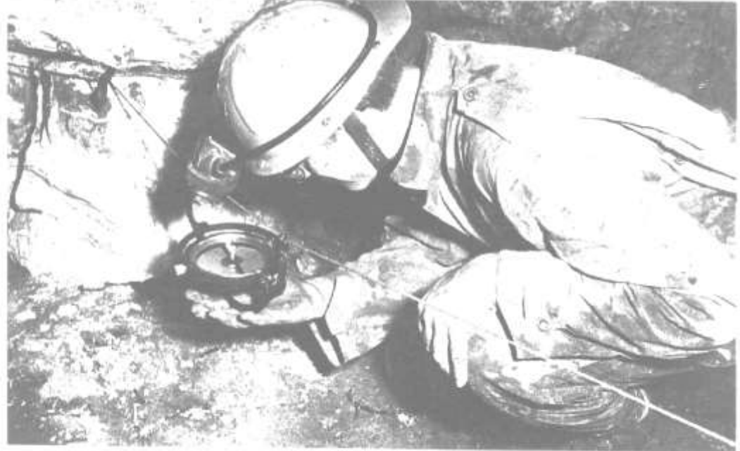
Rilievo di precisione, con l'utilizzo della bussola da miniera, nelle grotte vaporose del Monte Kronio (Suliccia) nel 1962 (Foto Archivio S.A.G.)
